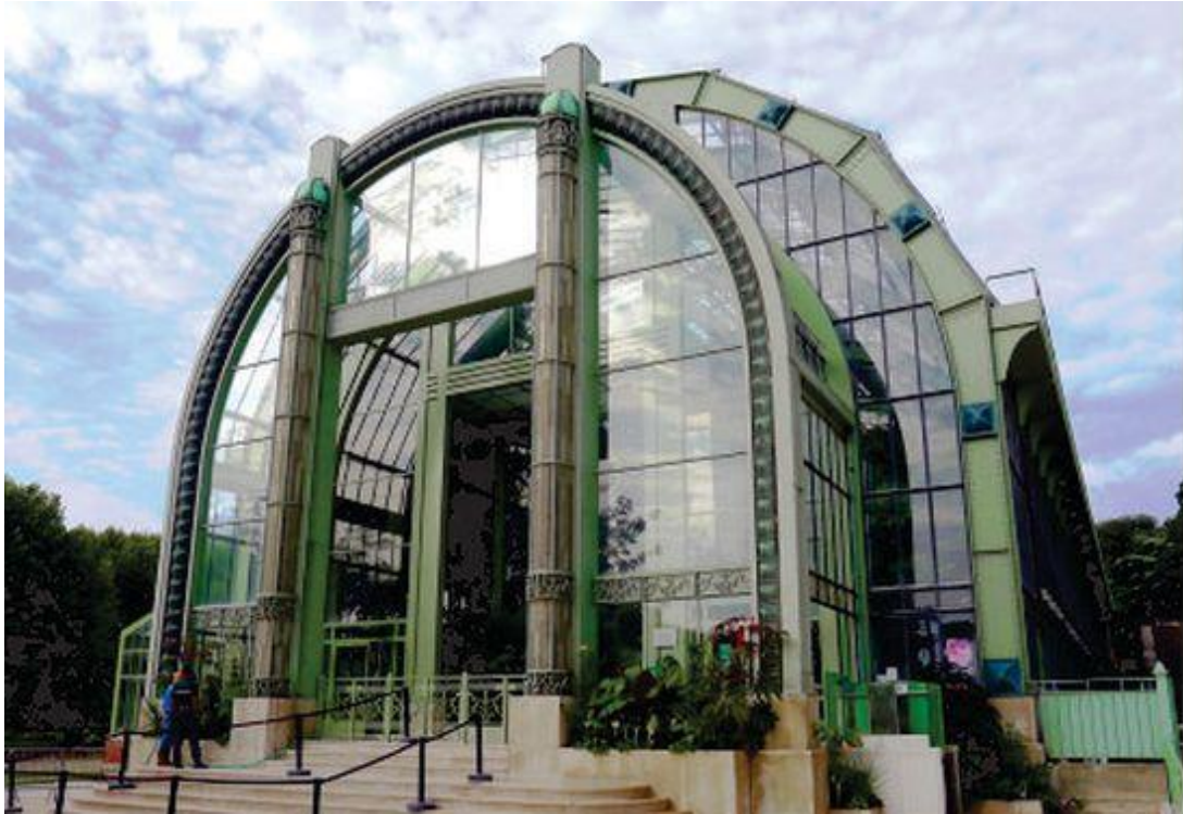
Estufa Australiana, Jardim das Plantas, Paris – Uma das primeiras grandes construções em ferro e vidro, projetada pelo arquiteto
